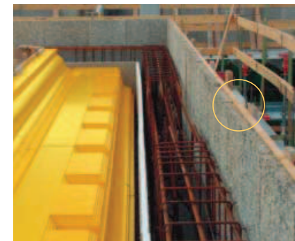
MATRIZE TOPFORM MIT EINFÜGUNG EINER ISOLIERPLATTE ZUR BESEITIGUNG DER WÄRMEBRÜCKE
