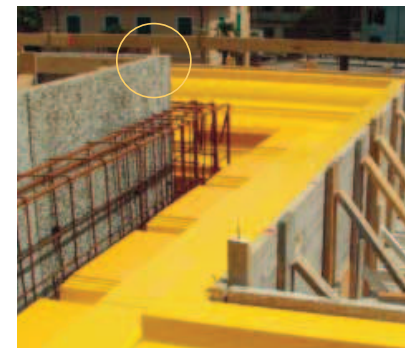
MATRIZE TOPFORM MIT EINFÜGUNG EINER ISOLIERPLATTE ZUR BESEITIGUNG DER WÄRMEBRÜCKE
